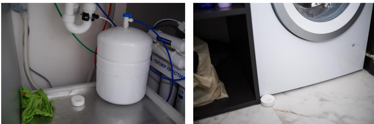
Рисунок 4 – Варианты установки датчика протечки*
