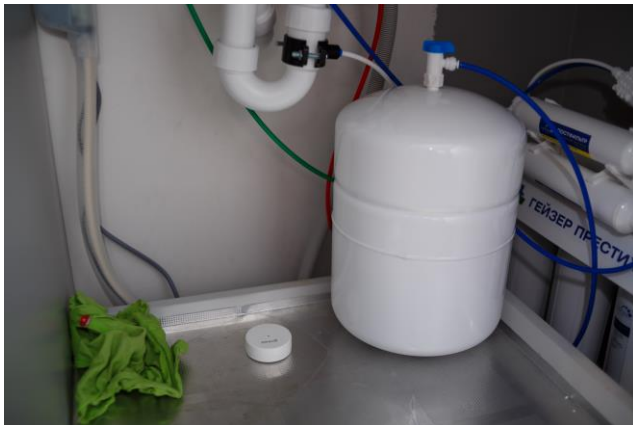
Малюнок 4 – Варіанти встановлення датчика протікання
